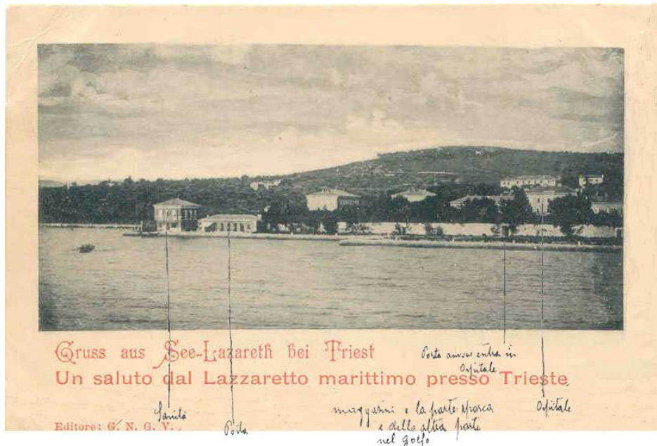
Abb. 2 Von links: Sanità (Sanitätsgebäude); Posta (Gebäude, in dem sich das Postamt befand; Magazzini e la parte sporca e della altre parti nel golfo (Magazine und der "unreine" Teil und der beim Golf /zu ergänzen: des Meeres/ gelegene Teil); Porta andare entra in ospitale (Eingangstor zum Krankenhaus; Ospitale (Krankenhaus).
